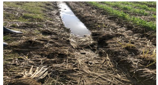
わらが周囲溝につまり滞水している状態
