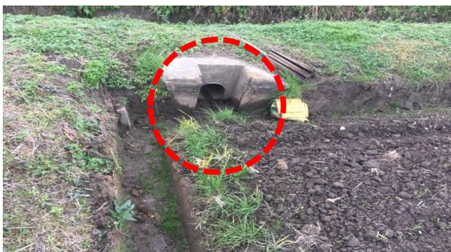
【周囲溝と排水口をつなげたほ場】
