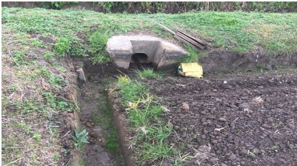
【周囲溝と排水溝をつなげたほ場】
