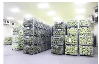
津屋崎予冷库完成
