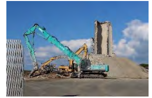
津屋崎カントリーエレベーター解体工事
